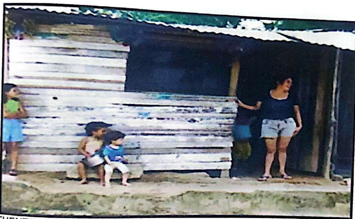
Fotografía 15. Viviendas en mal estado
