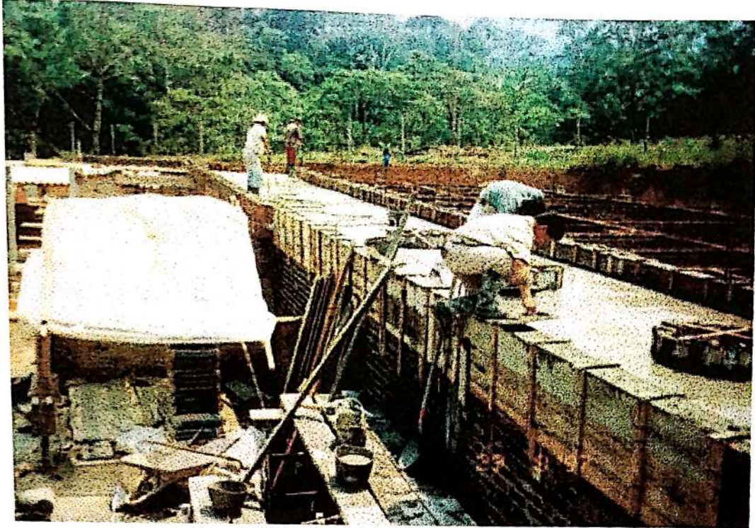
Foto 7. Avance construcción nueva sede Casa Hogar del Anciano de Mocoa
