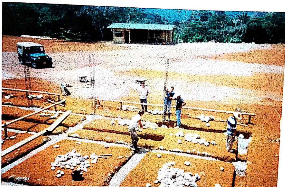
Foto 5. Inicio construcción de la nueva sede Casa Hogar del Anciano de Mocoa
