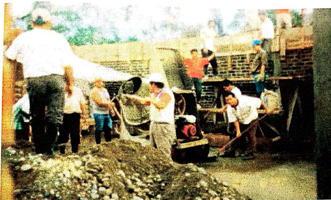
Foto 12. Trabajos comunitarios en la nueva sede de la Casa Hogar del Anciano
