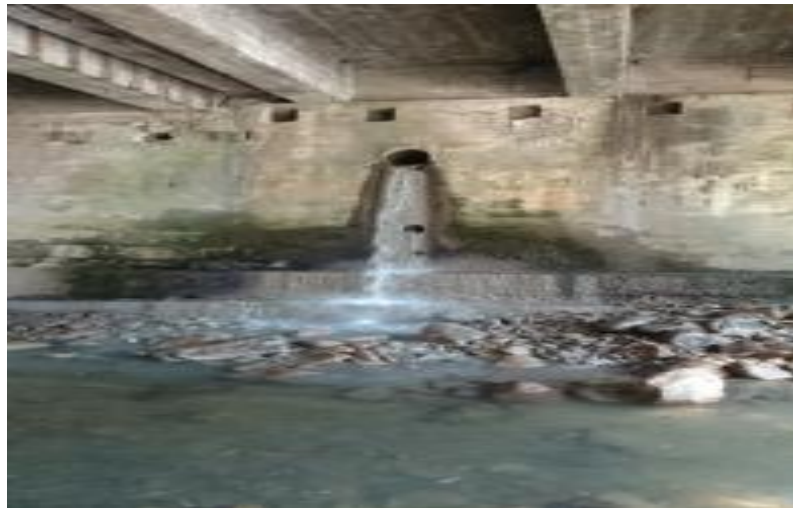
Figura 50. Punto de Vertimiento. Puente Av. Colombia – Centro
