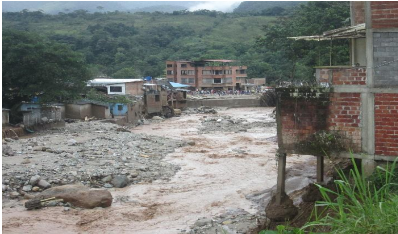
Figura 22. Estado actual del barrio la independencia
