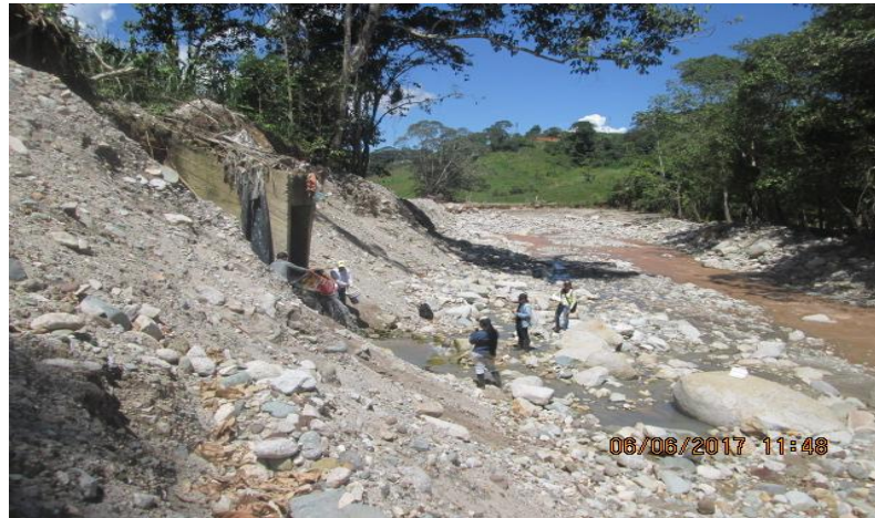
Figura 26. Box culvert barrio Los Prados
