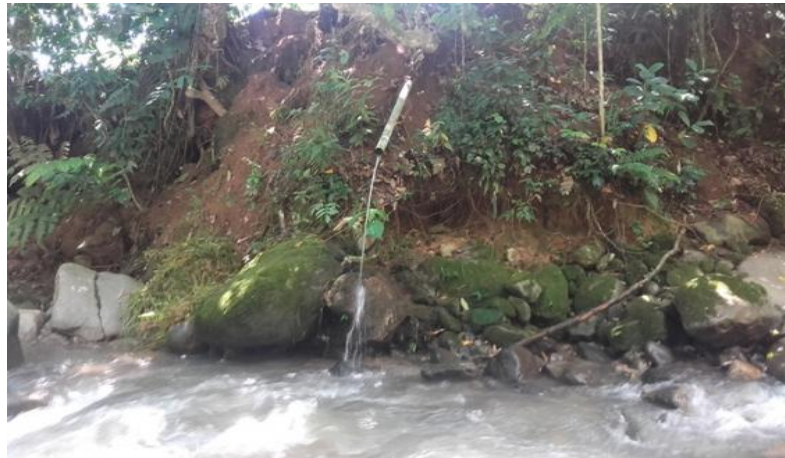
Figura 11. Aguas residuales domésticas
