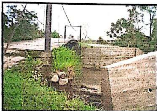
Figura No. 40 puente colgante y estribos en concreto
