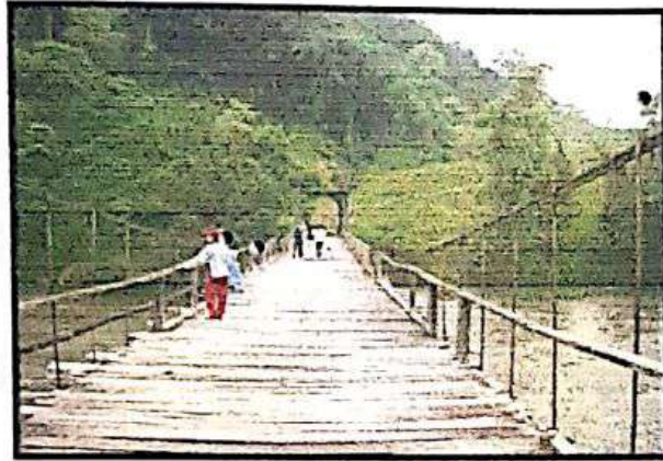
Figura No. 33 Puente Colgante Chantajea
