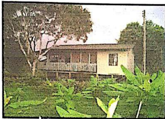
Figura No. 41 casa en madera
