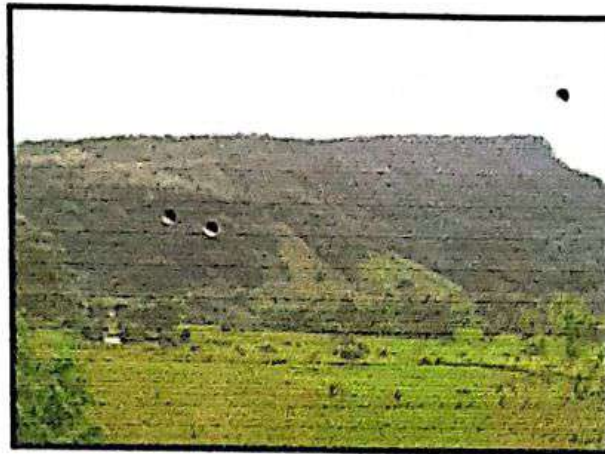
Figura No. 20 serranía del churumbelo, ubicación de la torre
