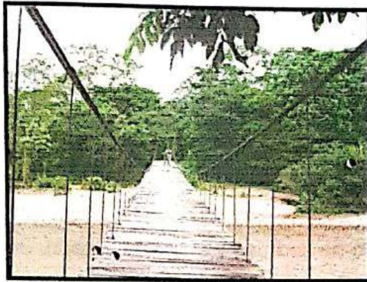
Figura No. 39 puente colgante sobre el río Guineo
