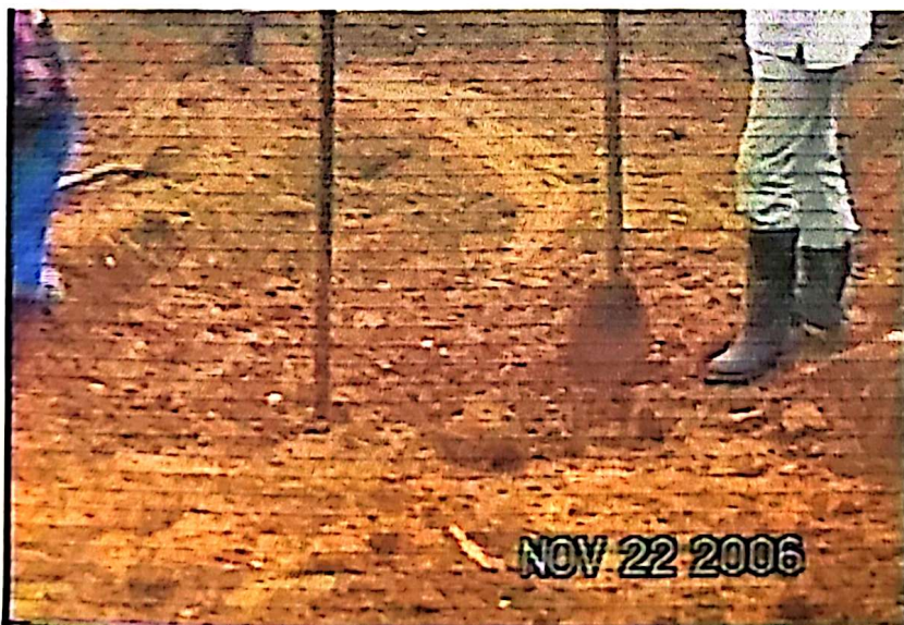
Foto N° 7. Nivelación del terreno
