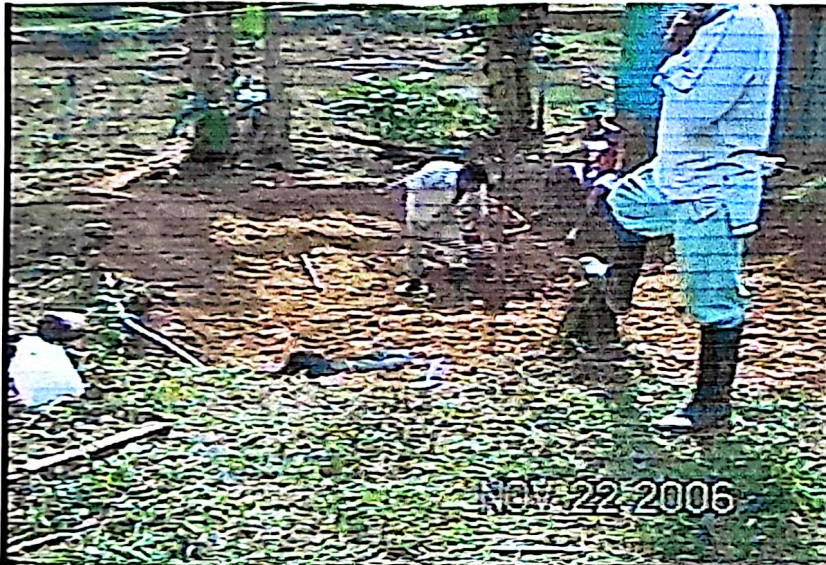
Foto N° 6. Remoción de cobertura vegetal (descapote)
