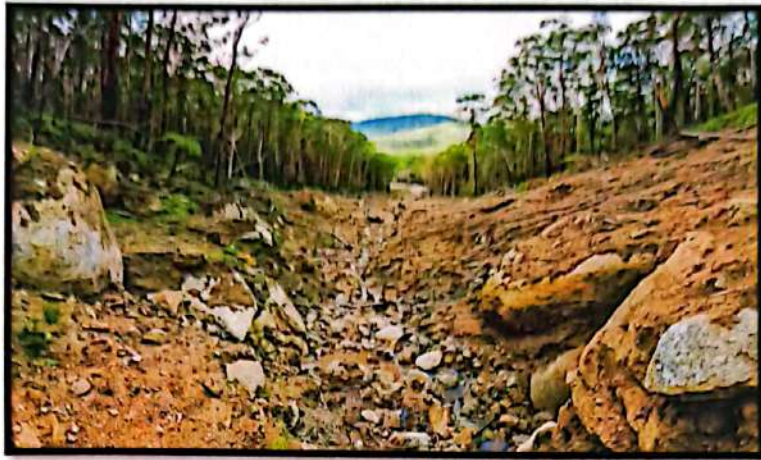
Imagen 6. Erosión en Bancos Aluviales
