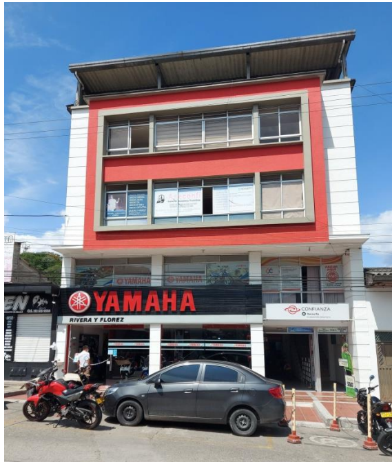
Ilustración 4 Fachada principal JOAPRAEZ
