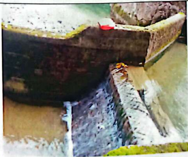
Fotografía 3. Estructura de la bocatoma
