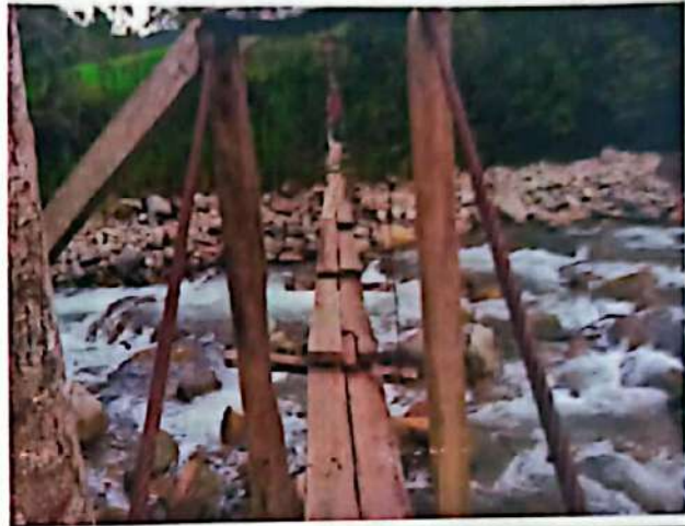
Entrada al Fotografía 2. Puente colgante hacia el área de estudio.
