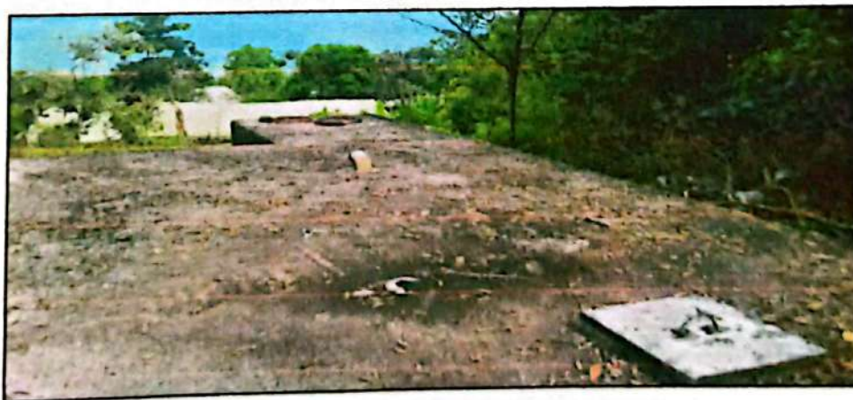
Figura 12 Tanque desarenador Taruquita
