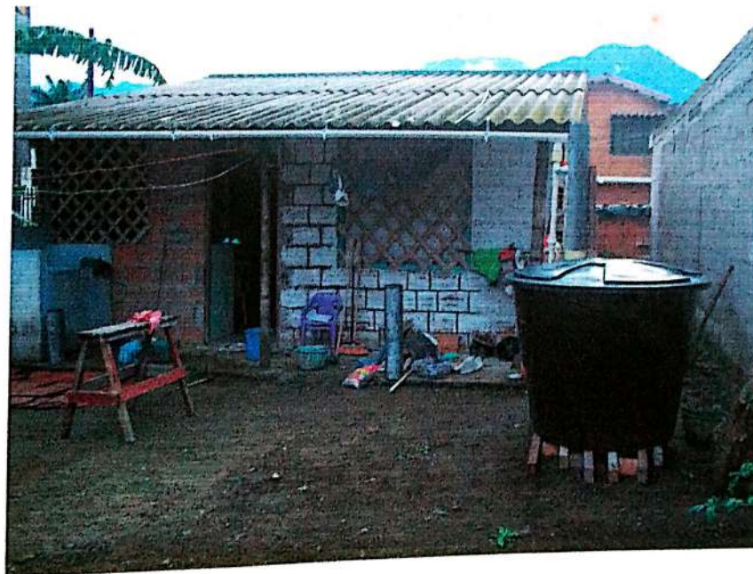
Sistema de recolección y tratamiento de aguas lluvias
