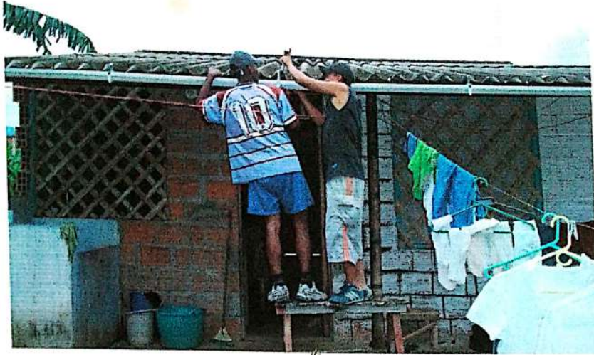
Construcción del sistema
