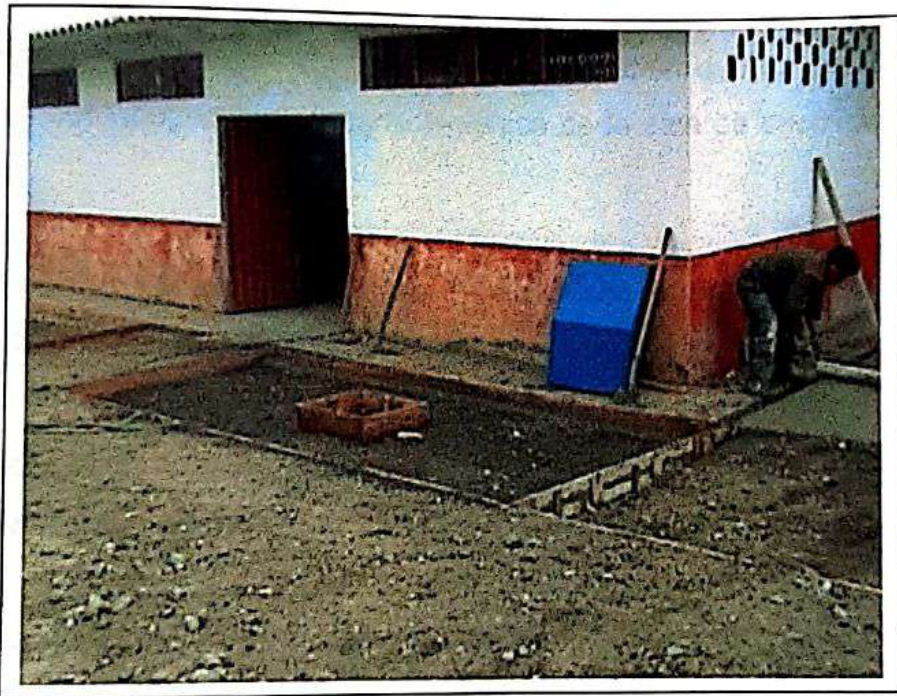
Figura 15. Obras para el Mejoramiento de las Instalaciones del Matadero
