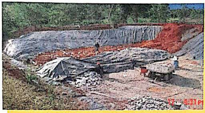
Fotografía 4: Disposición Final de Residuos Sólidos en el Relleno Sanitario
