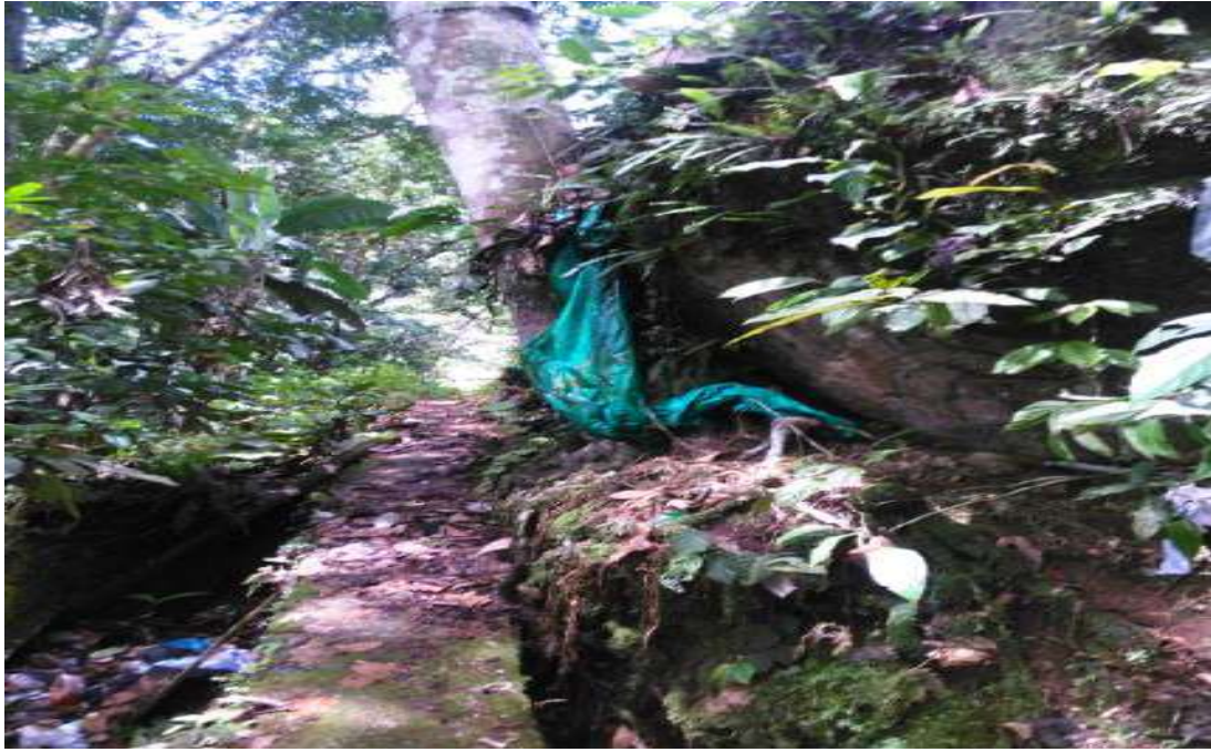
Fotografía 4 Mala disposición de residuos sólidos sobre la red de tuberías
