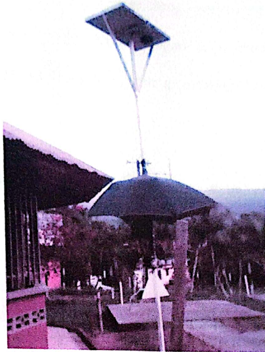
IMAGEN 6. Prototipo solar en su totalidad, ya instalado y funcionando.
