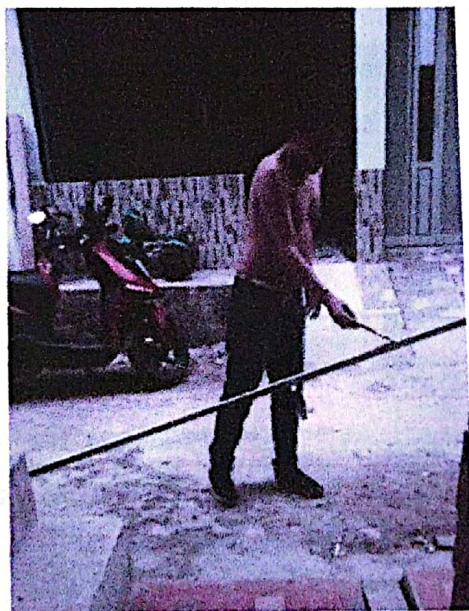
IMAGEN 2 Pintando el marco con pintura anticorrosiva. Cámara del celular.
