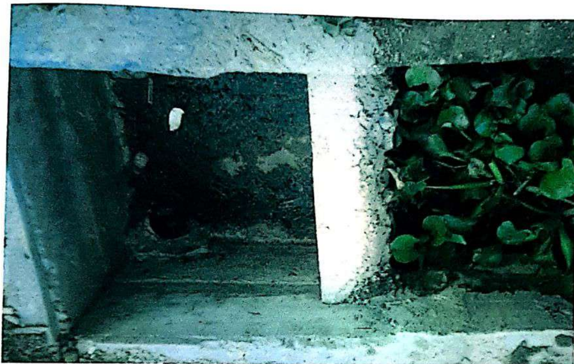
Figura 10. Buchon de agua para tratamiento de lixiviados
