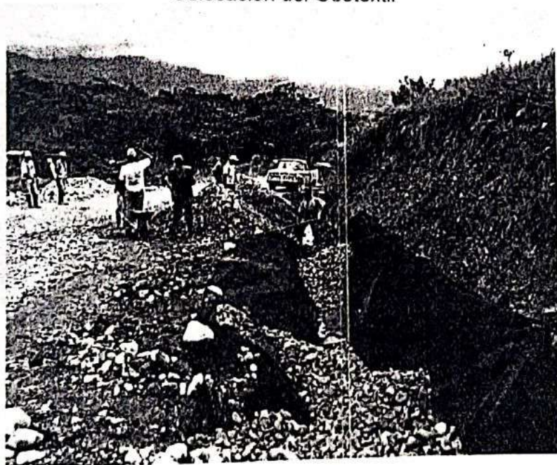
Colocación del Geotextil
