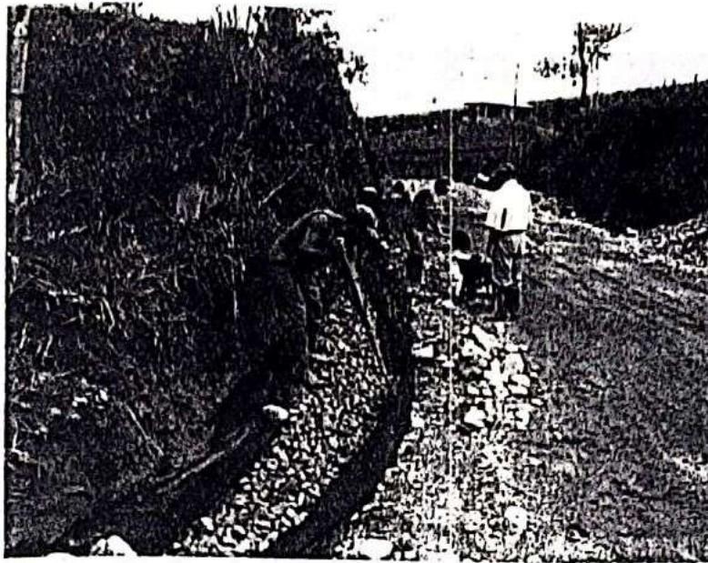
Colocación del material filtrante
