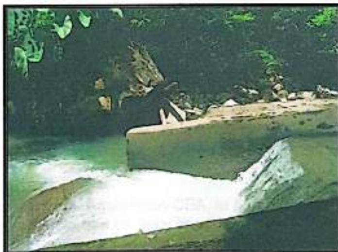
Figura 4. Bocatoma quebrada Anayaco
