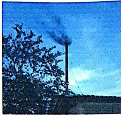
Foto 17. Chimenea del horno incinerador emitiendo gases y material particulado producto de la incineración de residuos peligrosos.
