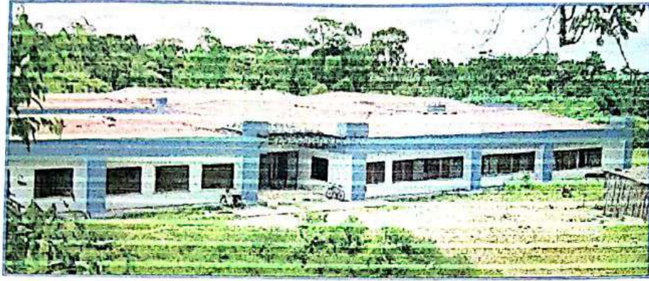
Foto 2. Infraestructura en construcción para la nueva sede de la E.S.E. Hospital Sagrado Corazón de Jesús en el área de expansión del casco urbano de la Hormiga.
