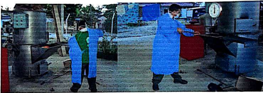
Foto 15. Horno incinerador HI-30 en operación; el operario no cuenta con los elementos de bioseguridad necesarios para este tipo de actividad.
